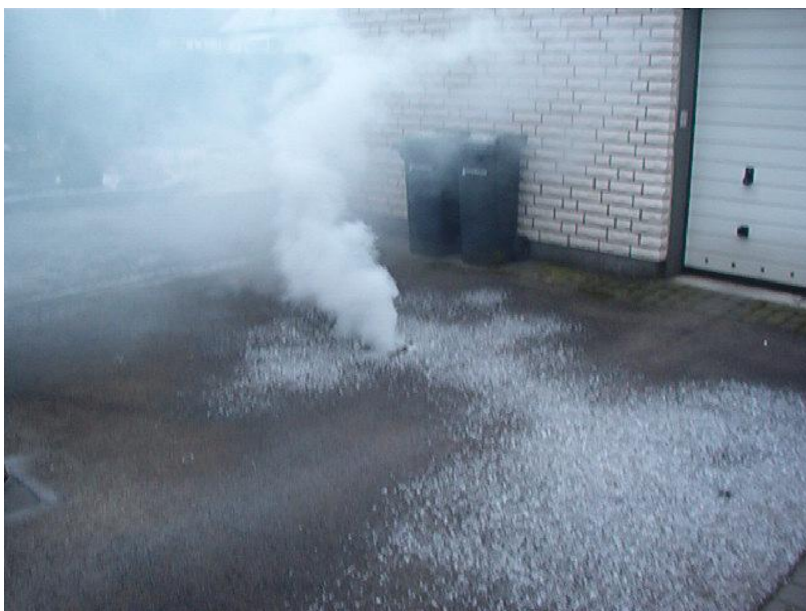
Fehlanschluss eines Hofablaufes
