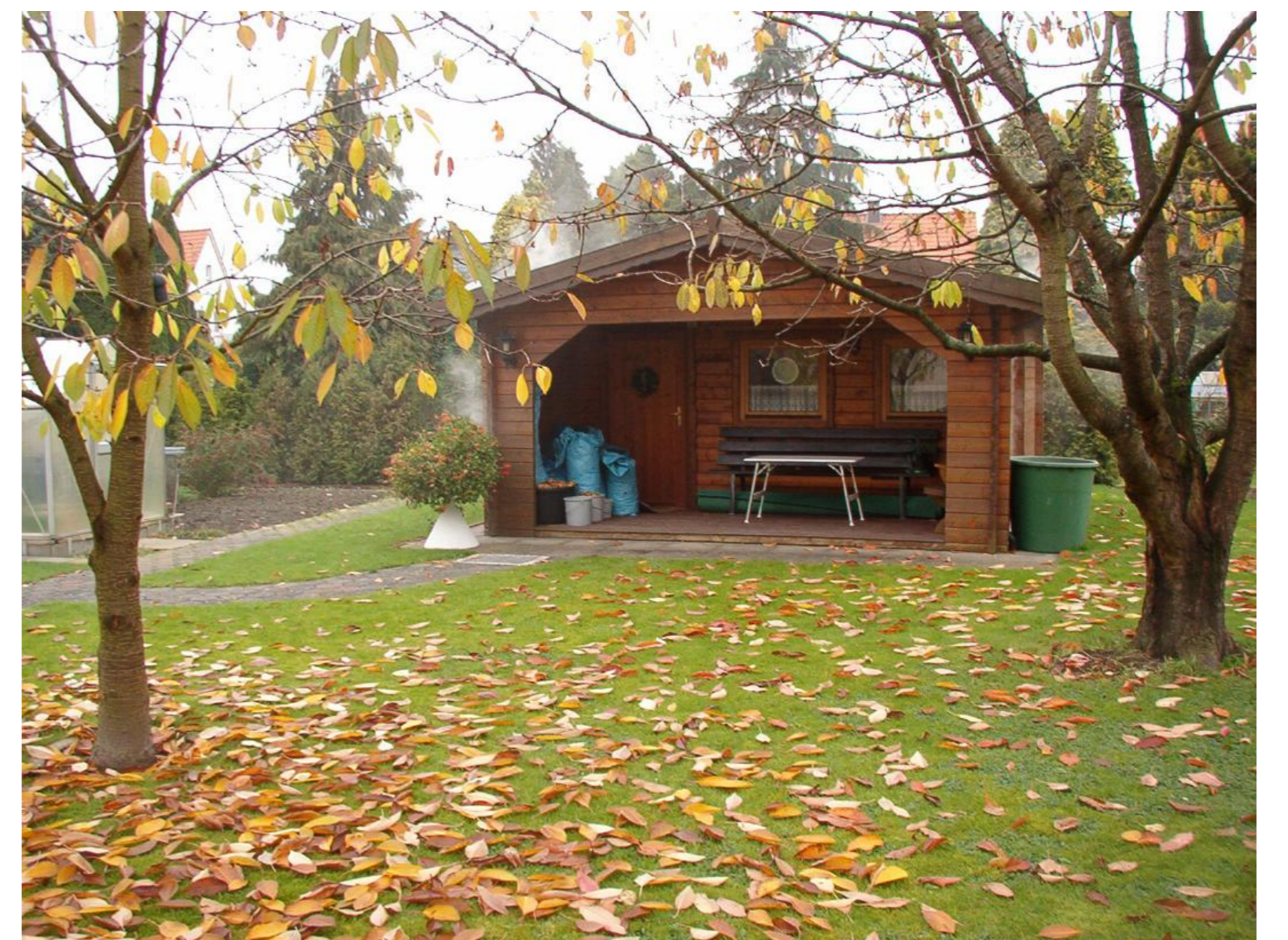
Gartenhaus entwässert in die alte Klärgrube
