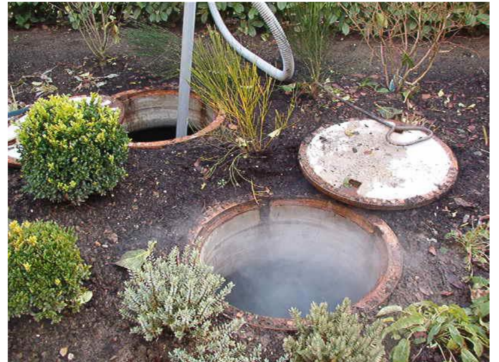
Querverbindung zwischen Schmutz- und Regenwasserhausanschluss
